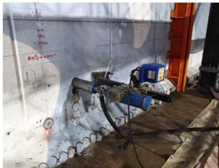
解体用コア削孔 (STEP3) 2018/4/24撮影
