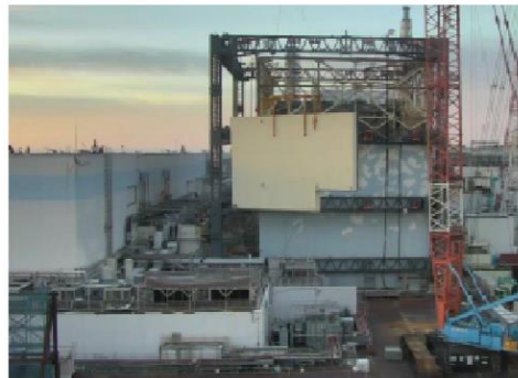
⑤ 【2016年11月10日：壁パネル取り外し完了】
