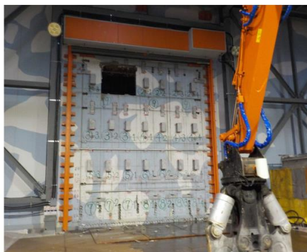
壁解体(STEP6) 2018/5/28撮影
