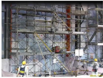
調査用コア採取の作業状況（全景）
