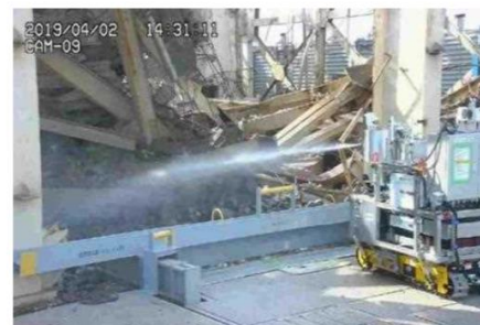
飛散防止剤散布状況
