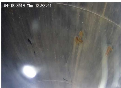
筒身内部調査の実施状況写真
