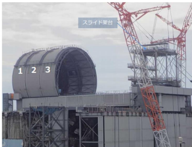
ドーム屋根設置状況 (撮影日:2017年10月17日)
