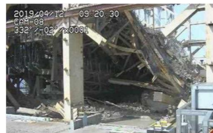
小ガレキ撤去状況
