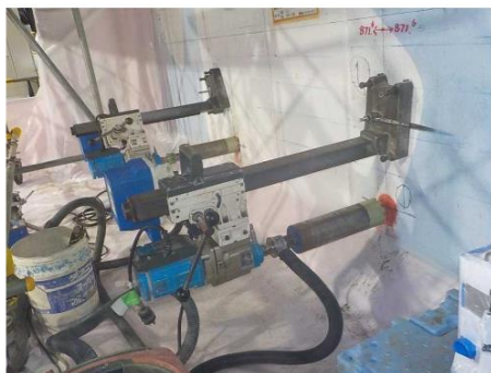
コア削孔装置設置状況
