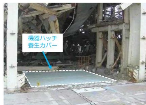
機器ハッチ養生カバー設置後 (西作業床より)
