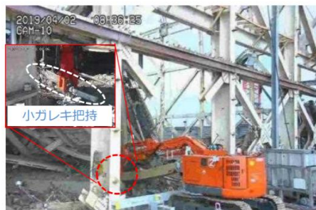
遠隔操作重機による作業状況
