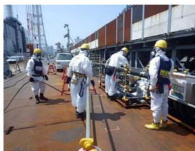
写真③ ケーブル敷設作業状況
