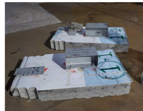
壁解体 (STEP6) 2018/5/28撮影
