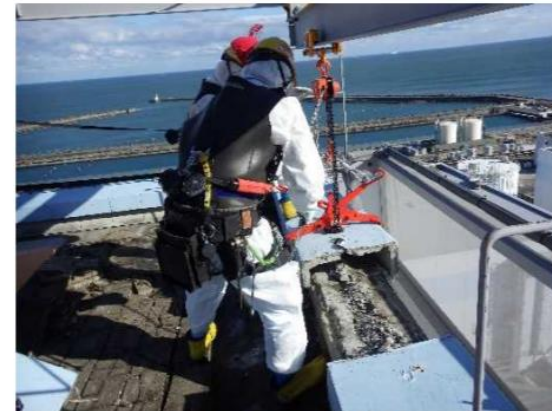
屋上での笠木撤去状況
