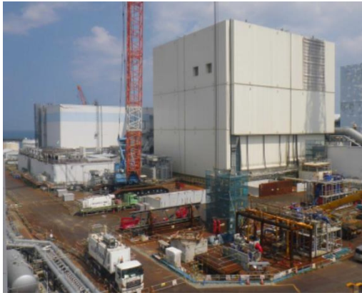
作業開始前の状況写真 (7月11日撮影)
