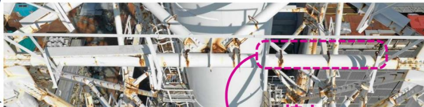
【写真①】 地上約76mの南側水平材
