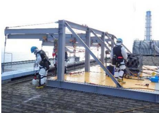
架台設置状況（原子炉建屋屋上）
