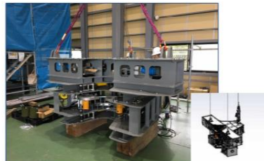
鉄塔解体装置（支柱材用）組立状況
