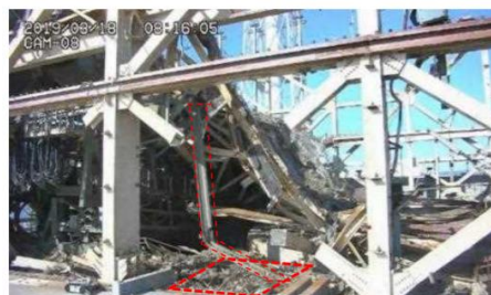
小ガレキ撤去前
