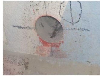
調査用コア採取の状況
