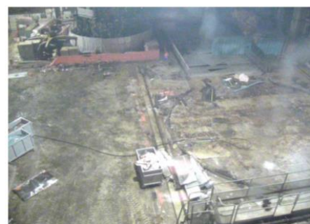
②残置物片付後 (北側) 撮影日(10/22)
