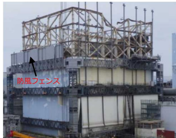
防風フェンス設置状況(11月9日撮影)
