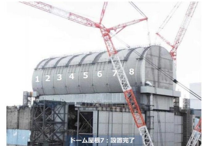
ドーム屋根7設置完了 (撮影日2018年2月28日)
