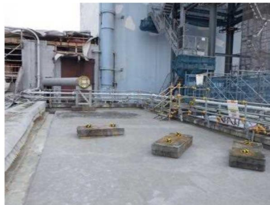
FSTR建屋片付け状況
