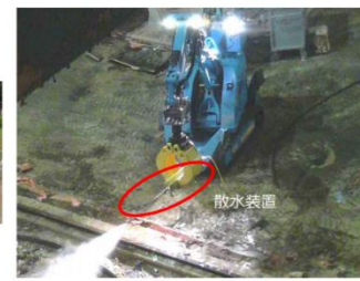
① 散水状況 (ダスト抑制対策)
