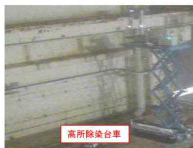
⑤高所空間／表面線量率測定状況
