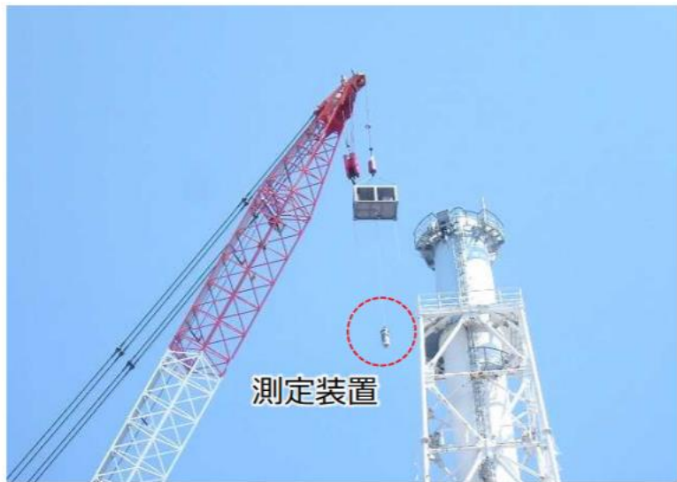
解体前調査の実施状況
