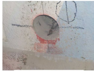
調査用コア採取の状況
