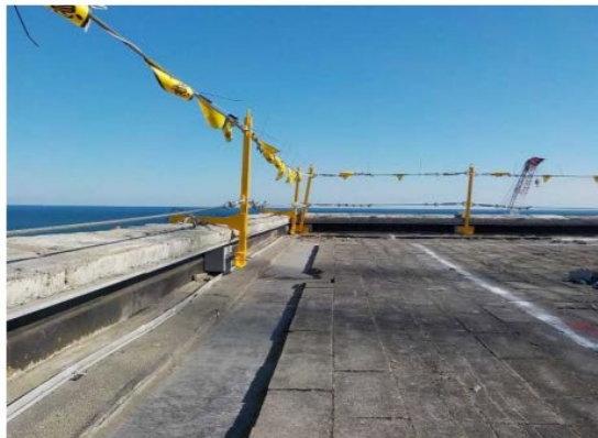
桁木等撤去後の手摺り設置状況
