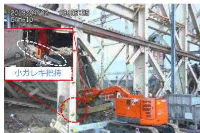
遠隔操作重機による作業状況
