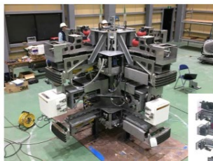
筒身解体装置 組立状況
