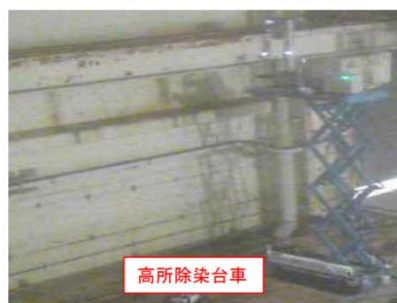
⑤高所空間／表面線量率測定状況
