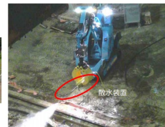
① 散水状況 (ダスト抑制対策)
