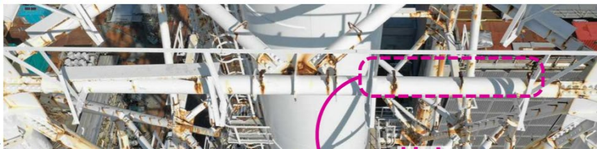
【写真①】 地上約76mの南側水平材
