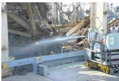
飛散防止剤散布状況
