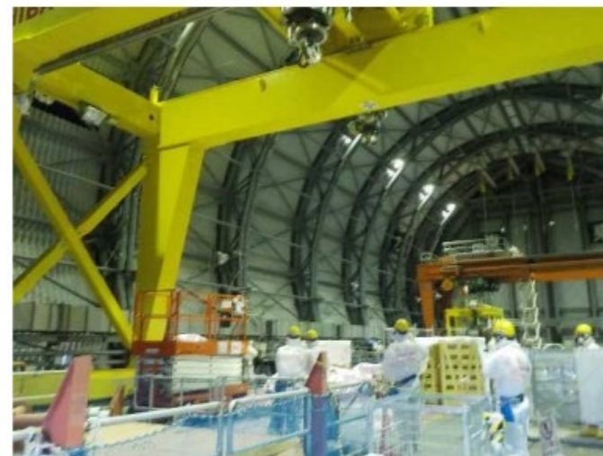
(クレーン試運転の様子(3号機オペレーティングフロア))
