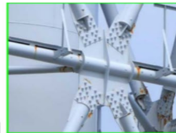
健全と判断した箇所の例
