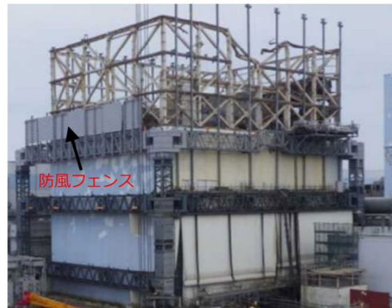
防風フェンス設置状況(11月9日撮影)
