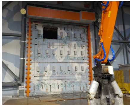
壁解体(STEP6) 2018/5/28撮影
