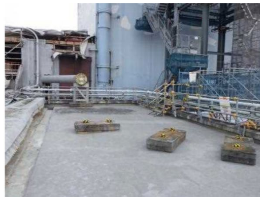
FSTR建屋片付け状況
