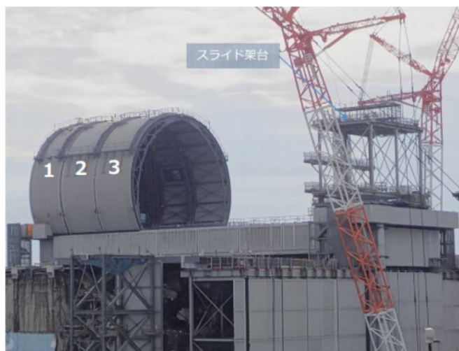
ドーム屋根設置状況 (撮影日:2017年10月17日)
