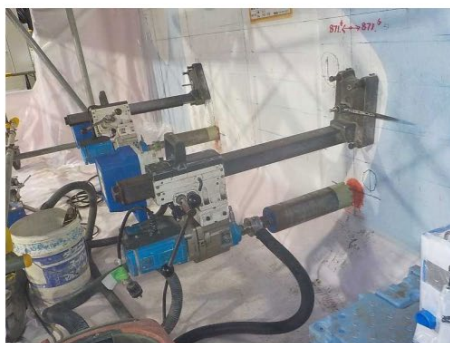
コア削孔装置設置状況
