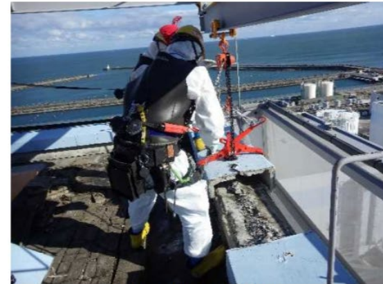
屋上での桁木撤去状況
