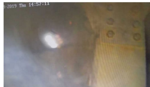
筒身内部支障物（H鋼）写真
