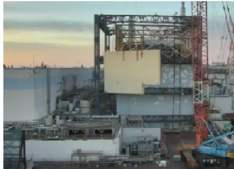
⑤ 【2016年11月10日：壁パネル取り外し完了】
