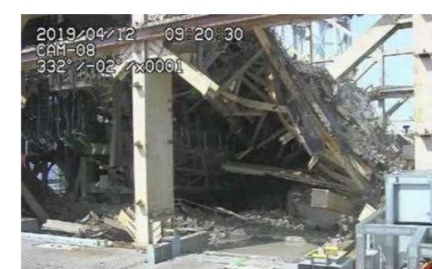
小ガレキ撤去状況
