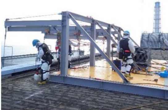
架台設置状況（原子炉建屋屋上）
