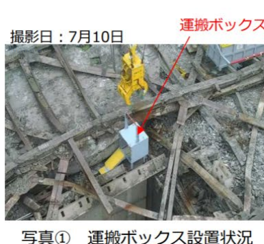
写真① 運搬ボックス設置状況
