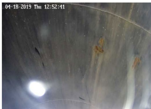
筒身内部調査の実施状況写真
