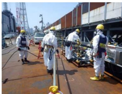
写真③ ケーブル敷設作業状況
