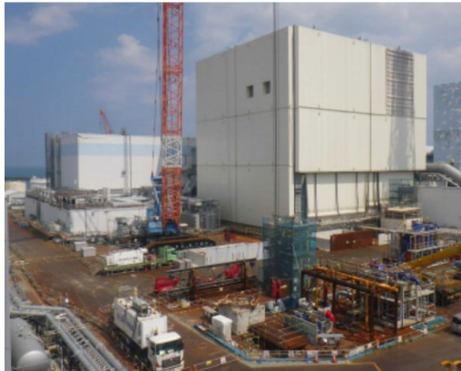
作業開始前の状況写真 (7月11日撮影)
