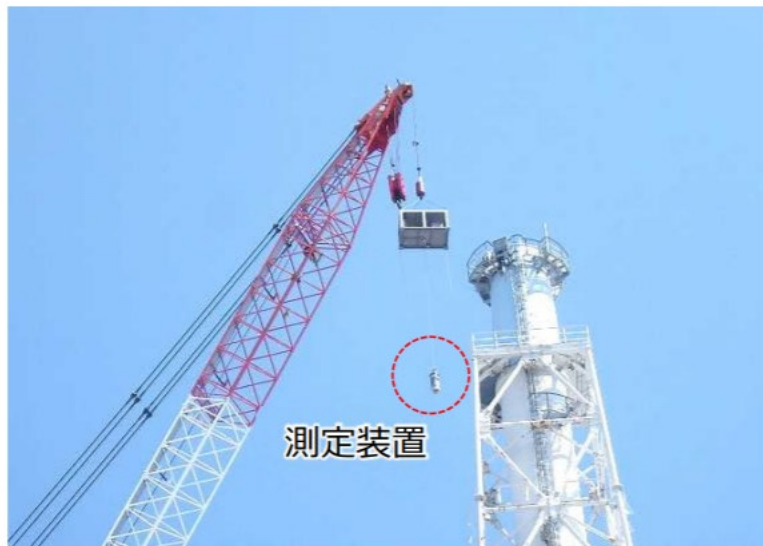
解体前調査の実施状況
