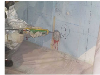
調査箇所の孔塞ぎ状況
