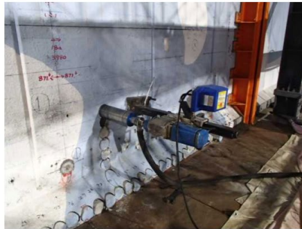
解体用コア削孔 (STEP3) 2018/4/24撮影
