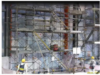
調査用コア採取の作業状況（全景）
