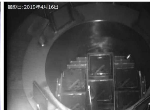
輸送容器へ燃料装填完了(7体)
