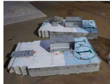
壁解体 (STEP6) 2018/5/28撮影
