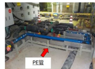
新規PE管施工後
