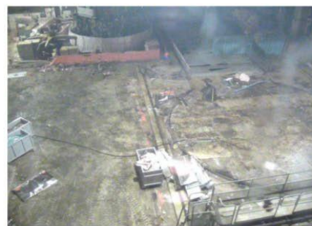
②残置物片付後 (北側) 撮影日(10/22)
