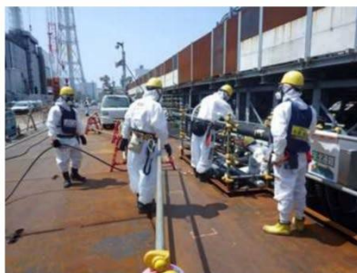
写真③ ケーブル敷設作業状況
