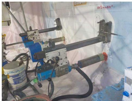
コア削孔装置設置状況
