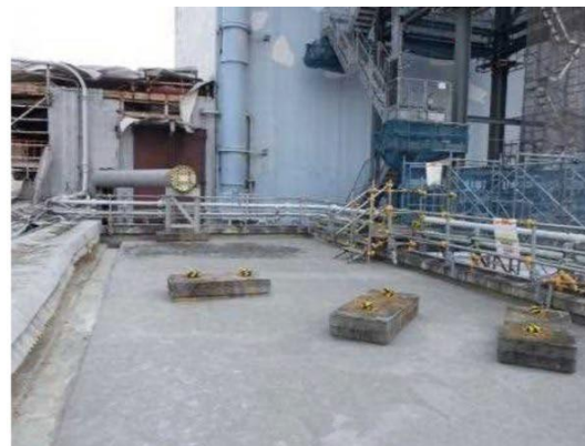
FSTR建屋片付け状況
