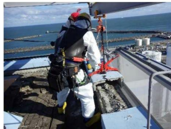
屋上での桁木撤去状況
