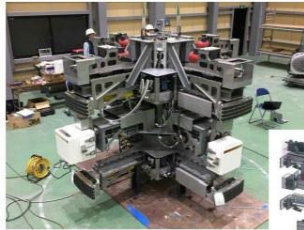
筒身解体装置 組立状況
