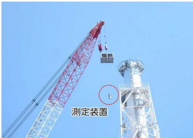
解体前調査の実施状況
