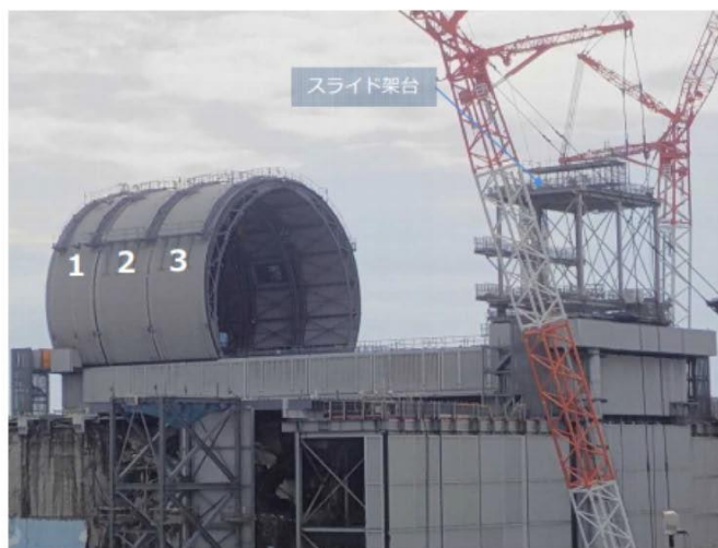
ドーム屋根設置状況 (撮影日:2017年10月17日)
