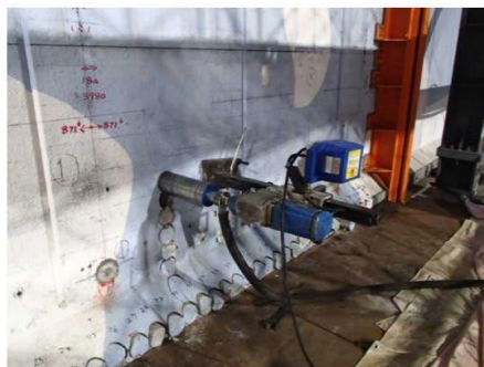
解体用コア削孔 (STEP3) 2018/4/24撮影
