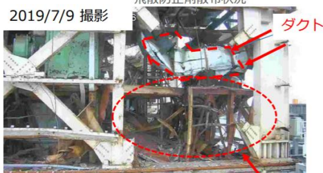
南側小ガレキ撤去前
