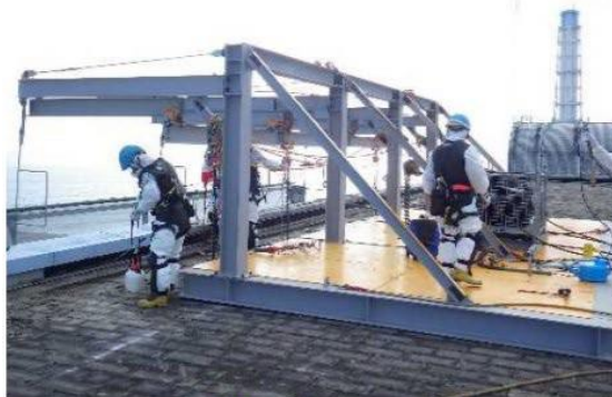
架台設置状況（原子炉建屋屋上）
