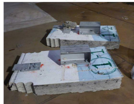
壁解体 (STEP6) 2018/5/28撮影
