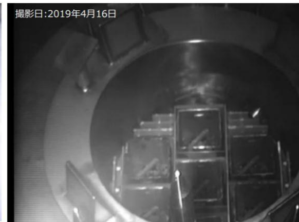
輸送容器へ燃料装填完了(7体)
