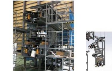
鉄塔解体装置（斜材用）組立状況
