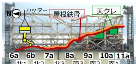
図1 崩落屋根形状(西面より)
