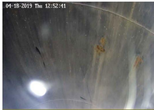
筒身内部調査の実施状況写真
