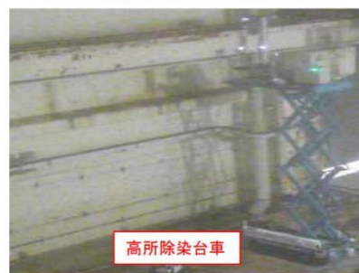
⑤高所空間／表面線量率測定状況
