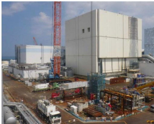
作業開始前の状況写真 (7月11日撮影)
