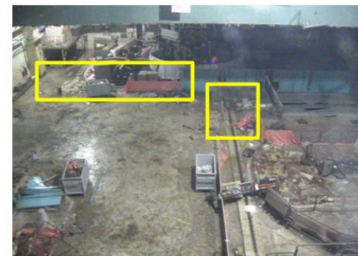
②残置物移動片付後(北側)
