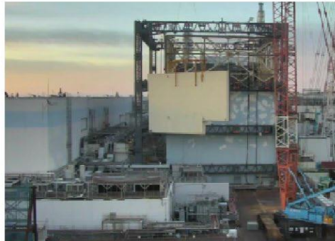
⑤ 【2016年11月10日：壁パネル取り外し完了】
