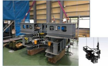
鉄塔解体装置（支柱材用）組立状況
