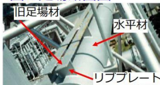
【参考】 改造工事前の足場写真 (昭和61年撮影)
