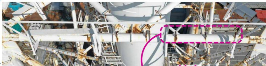
【写真①】 地上約76mの南側水平材
