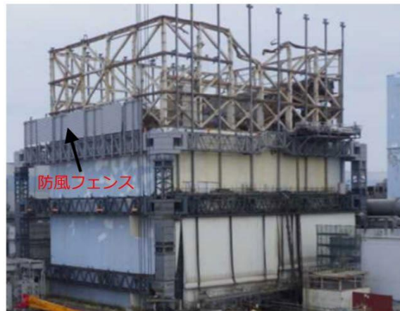
防風フェンス設置状況(11月9日撮影)
