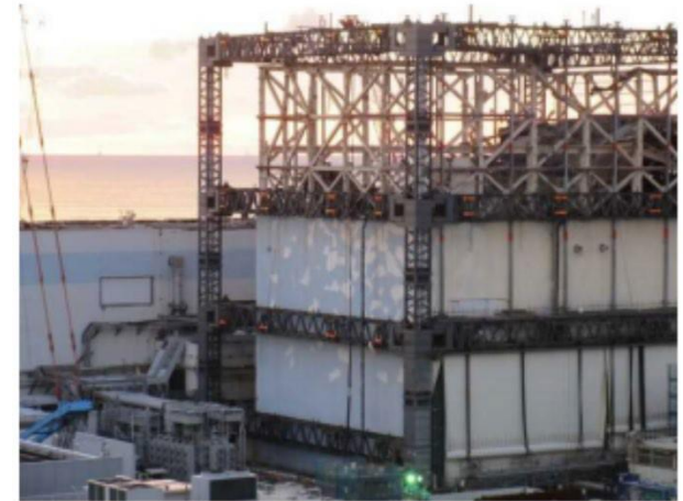
取り外し完了後の状況写真 (11月10日撮影)
