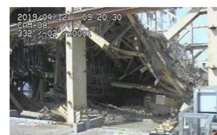
小ガレキ撤去状況
