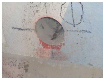
調査用コア採取の状況
