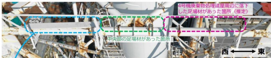
【写真①】 地上約76mの南側水平材（再掲）
