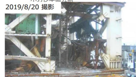
南側小ガレキ撤去後
