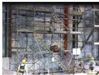
調査用コア採取の作業状況(全景)
