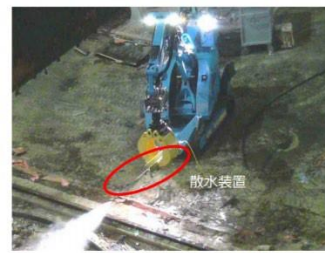
① 散水状況 (ダスト抑制対策)
