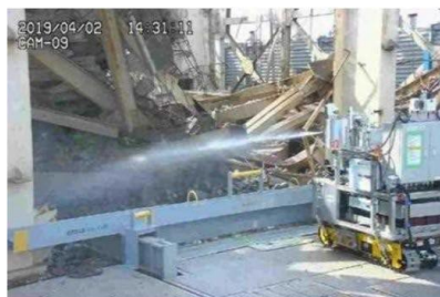
飛散防止剤散布状況
