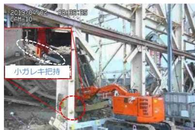
遠隔操作重機による作業状況
