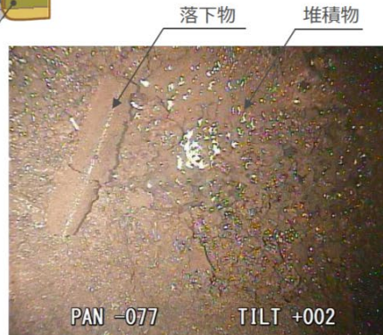
撮影場所B ペDESTAL底部
