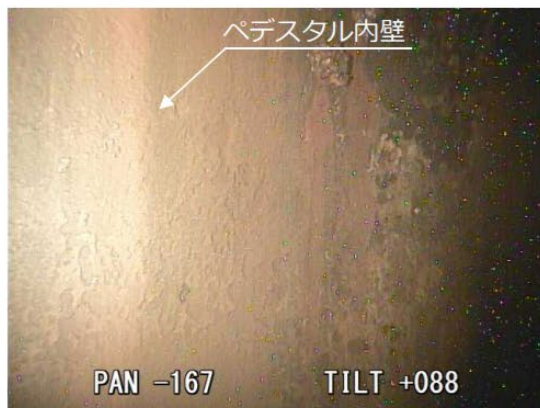
撮影場所D ペDESTAL内壁面
