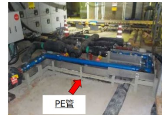
新規PE管施工後
