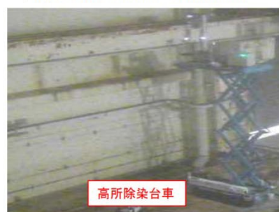
⑤高所空間／表面線量率測定状況
