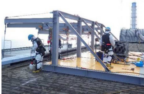
架台設置状況（原子炉建屋屋上）
