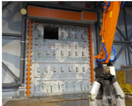
壁解体(STEP6) 2018/5/28撮影
