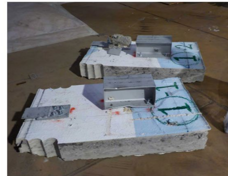
壁解体 (STEP6) 2018/5/28撮影
