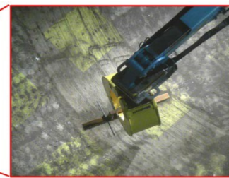
清掃用ブラシを用いて、床面の遊離性ダスト(砂等)を集め、集塵機で回収を行う。
