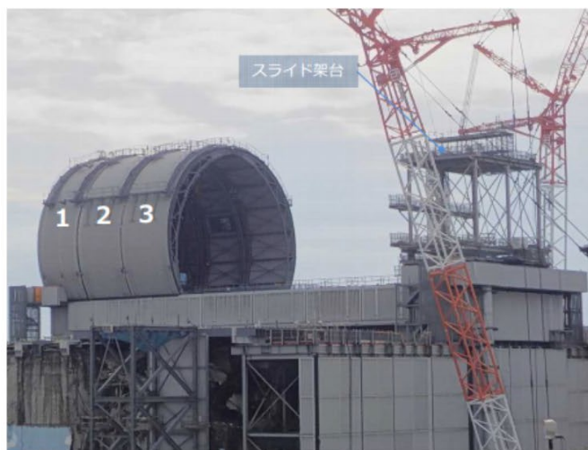
ドーム屋根設置状況 (撮影日:2017年10月17日)
