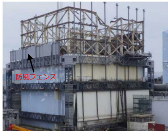
防風フェンス設置状況(11月9日撮影)
