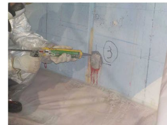
調査箇所の孔塞ぎ状況
