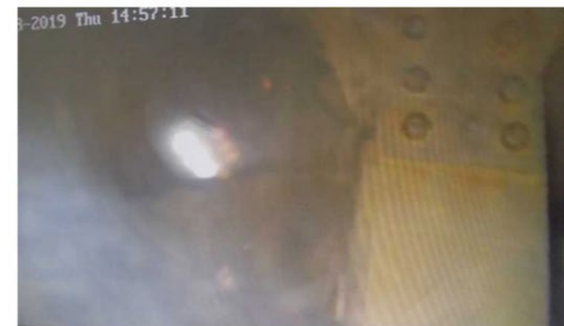
筒身内部支障物（H鋼）写真
