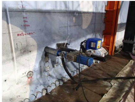
解体用コア削孔 (STEP3) 2018/4/24撮影
