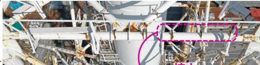
【写真①】 地上約76mの南側水平材
