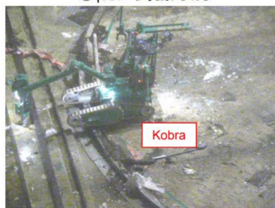
④低所表面汚染測定状況
