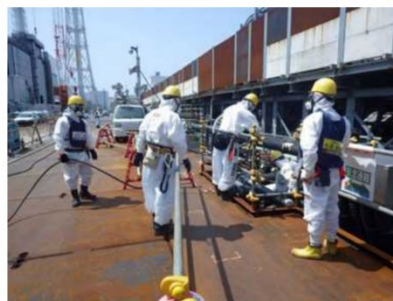
写真③ ケーブル敷設作業状況
