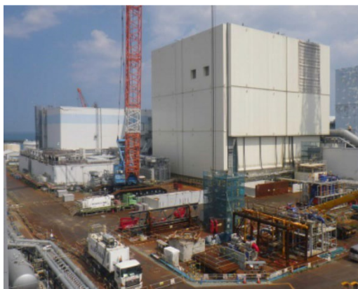
作業開始前の状況写真 (7月11日撮影)
