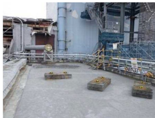
FSTR建屋片付け状況
