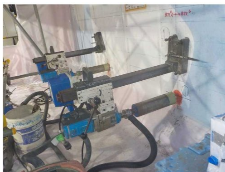
コア削孔装置設置状況
