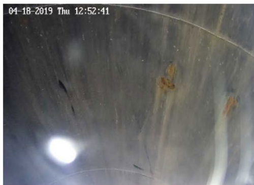
筒身内部調査の実施状況写真
