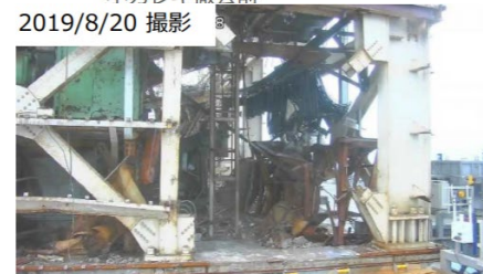
南側小ガレキ撤去後
