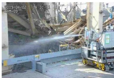
飛散防止剤散布状況
