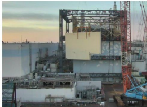
⑤ 【2016年11月10日：壁パネル取り外し完了】
