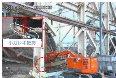
遠隔操作重機による作業状況
