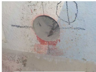
調査用コア採取の状況
