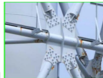
健全と判断した箇所の例
