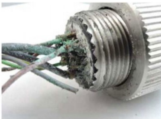
①接続部外観
