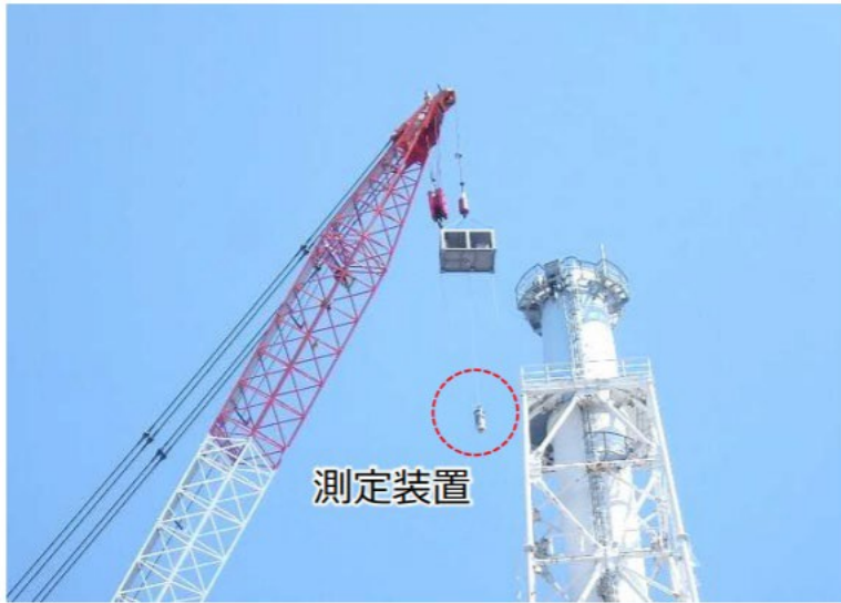
解体前調査の実施状況
