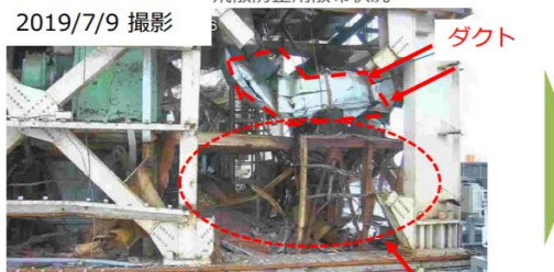
南側小ガレキ撤去前 既設架台等
