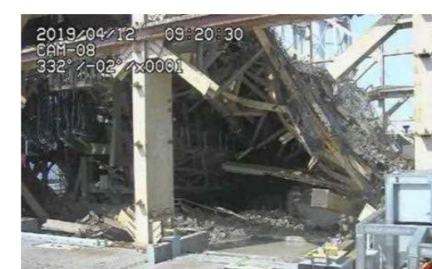
小ガレキ撤去状況
