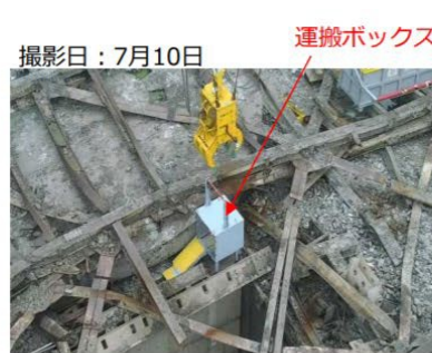
写真① 運搬ボックス設置状況
