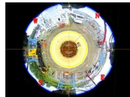
装置据付け時のカメラ画像
