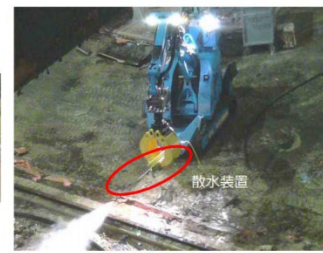
① 散水状況 (ダスト抑制対策)
