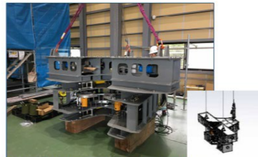
鉄塔解体装置（支柱材用）組立状況
