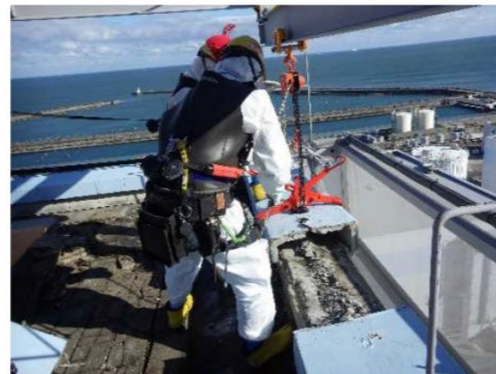
屋上での桁木撤去状況
