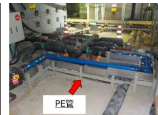
新規PE管施工後
