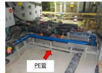
新規PE管施工後
