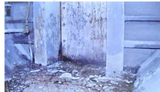
X-2ペネ内扉の状況 (A方向から撮影)
