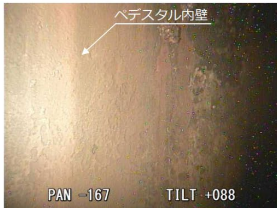
撮影場所D ペDESTAL内壁面
