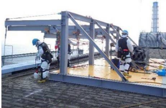
架台設置状況（原子炉建屋屋上）
