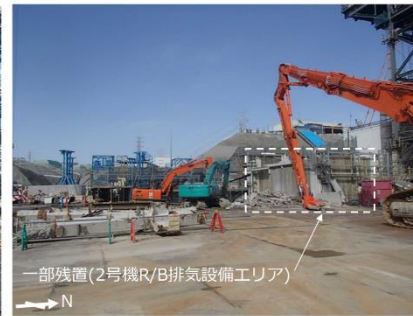
共用ボイラ建屋解体後(2020年3月撮)
