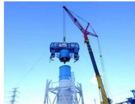
実証試験実施状況（2018.9.28）
