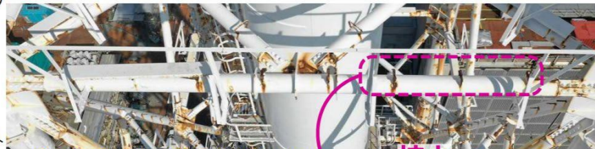
【写真①】 地上約76mの南側水平材
