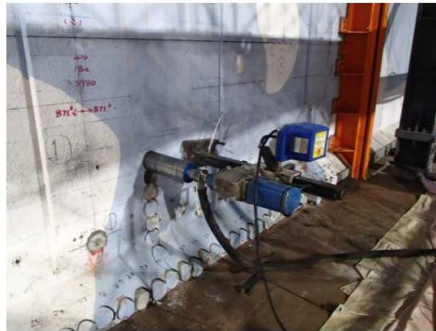
解体用コア削孔 (STEP3) 2018/4/24撮影
