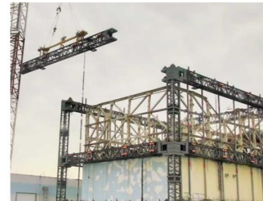
上部解体時の梁取り外し状況 撮影：2017.7
