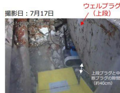
撮影日：7月17日 写真② 内部への侵入状況 (運搬ボックス内のカメラから撮影)
