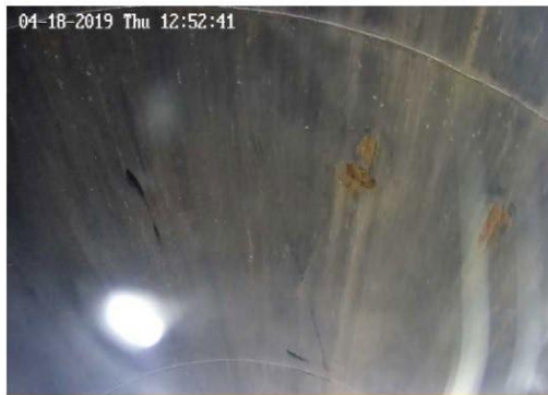
筒身内部調査の実施状況写真
