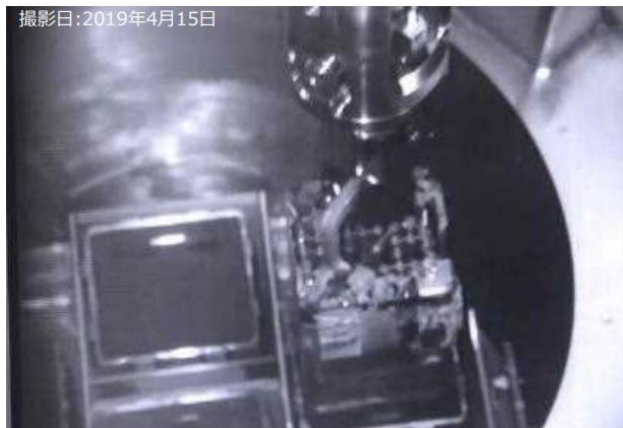
輸送容器へ燃料装填(1体目)
