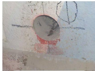
調査用コア採取の状況
