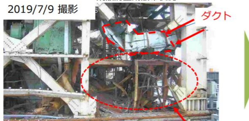
南側小ガレキ撤去前 既設架台等
