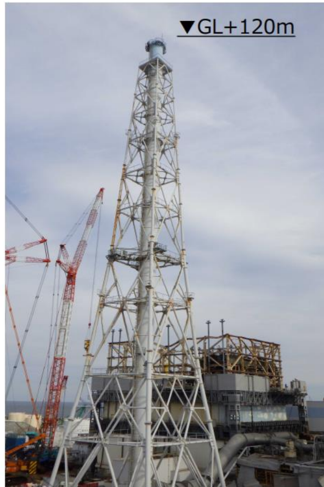
解体開始前 (2019年7月)
