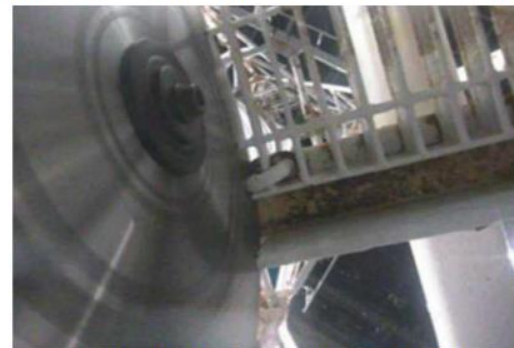
12ブロック目鉄塔解体作業(2月24日)
