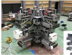
筒身解体装置 組立状況
