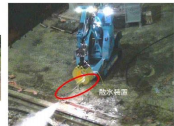
① 散水状況 (ダスト抑制対策)
