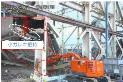
遠隔操作重機による作業状況
