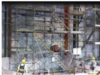
調査用コア採取の作業状況(全景)
