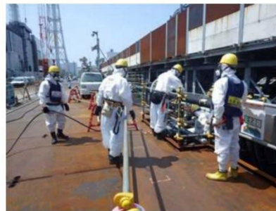
写真③ ケーブル敷設作業状況
