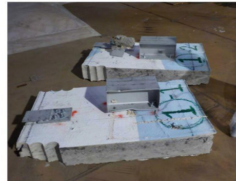
壁解体 (STEP6) 2018/5/28撮影
