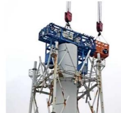
搭乗設備 作業状況
