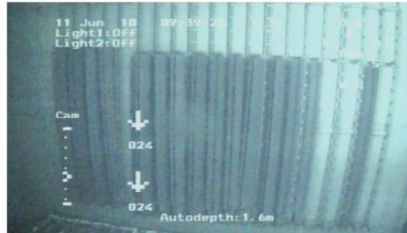
制御棒、制御棒ハンガー全体の様子
