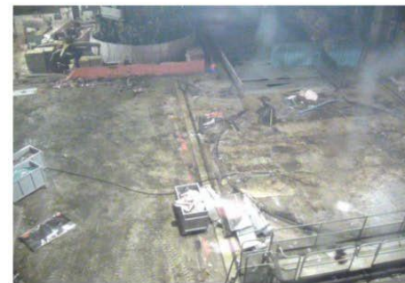
② 残置物片付後 (北側) 撮影日(10/22)
