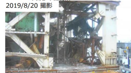
南側小ガレキ撤去後
