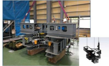
鉄塔解体装置（支柱材用）組立状況
