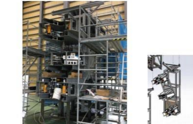
鉄塔解体装置（斜材用）組立状況
