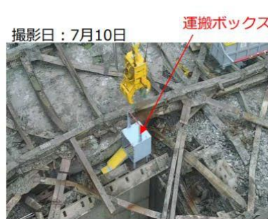
撮影日：7月10日 写真① 運搬ボックス設置状況
