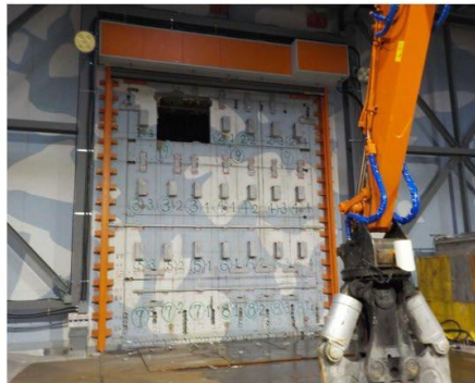
壁解体(STEP6) 2018/5/28撮影
