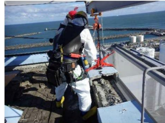
屋上での桁木撤去状況
