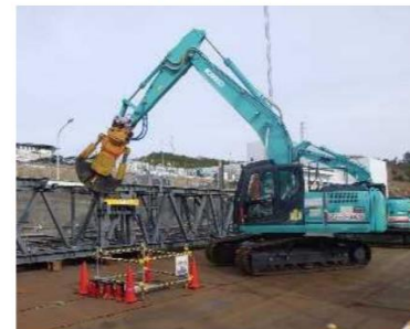
上部解体時の小割解体状況 撮影：2017.4
