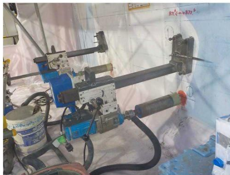
コア削孔装置設置状況
