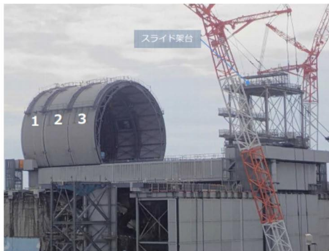
ドーム屋根設置状況 (撮影日:2017年10月17日)
