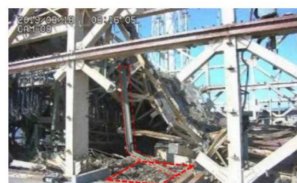
小ガレキ撤去前
