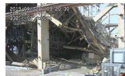
小ガレキ撤去状況
