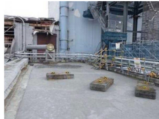
FSTR建屋片付け状況
