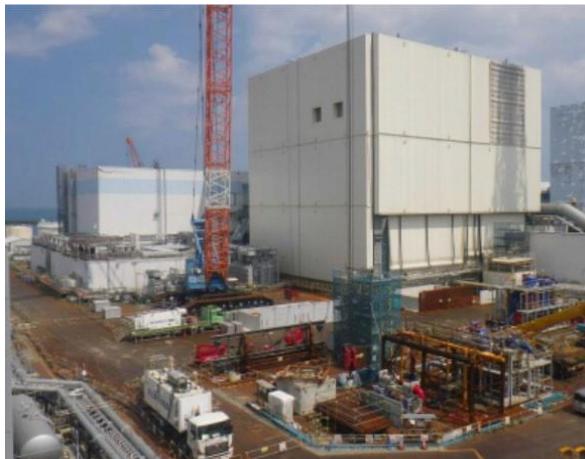
作業開始前の状況写真(2016年7月11日撮影)
