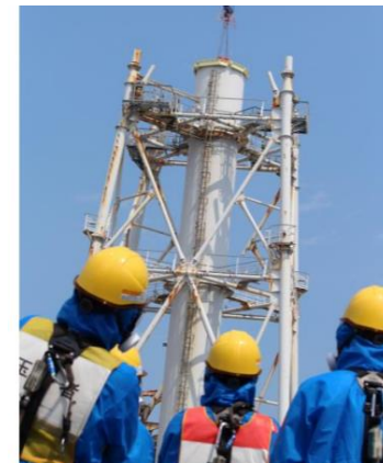
【作業を見守る解体作業員】
