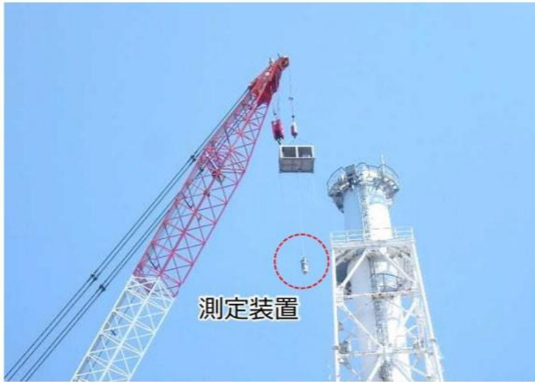
解体前調査の実施状況
