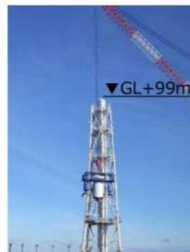
9ブロック解体後 (2020年1月17日)
