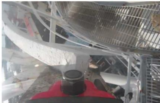
12ブロック目鉄塔解体作業(2月24日)
