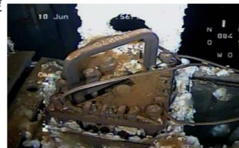
ワイヤー修復燃料上部の様子
